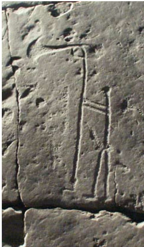
Nattfotografi, frottage och på motstående sida temporär imålning. Detalje af Simrislund 23, Österlen.
